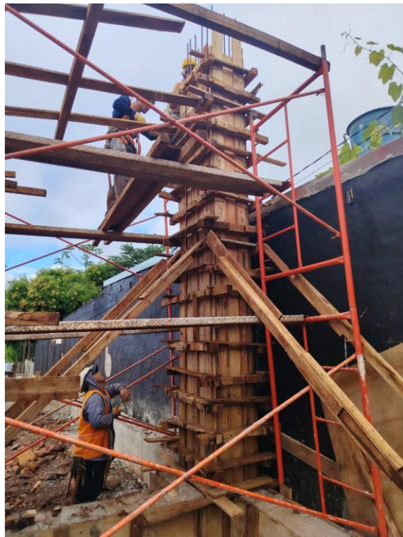
Armado, encofrado y hormigonado de pilares
